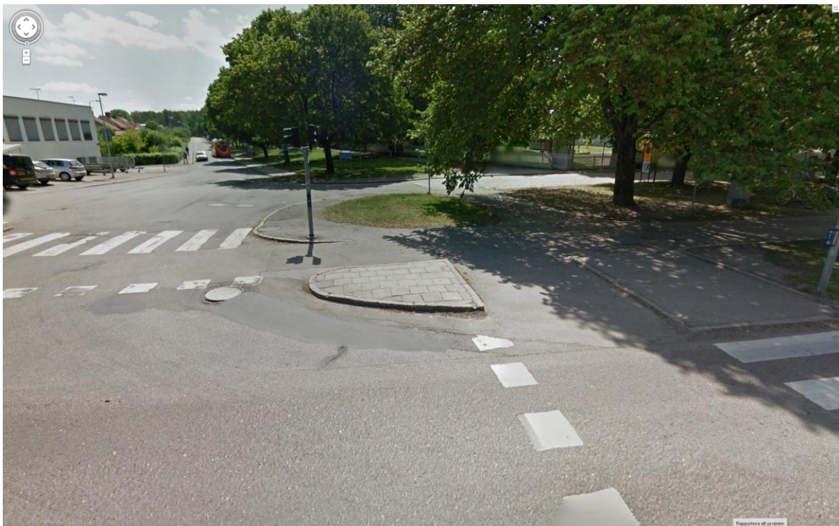
Figur 5. Vy från korsningen Malmslättsvägen/Majgatan söderut. Cykelöverfarten ansluter inte till någon cykelbana.
