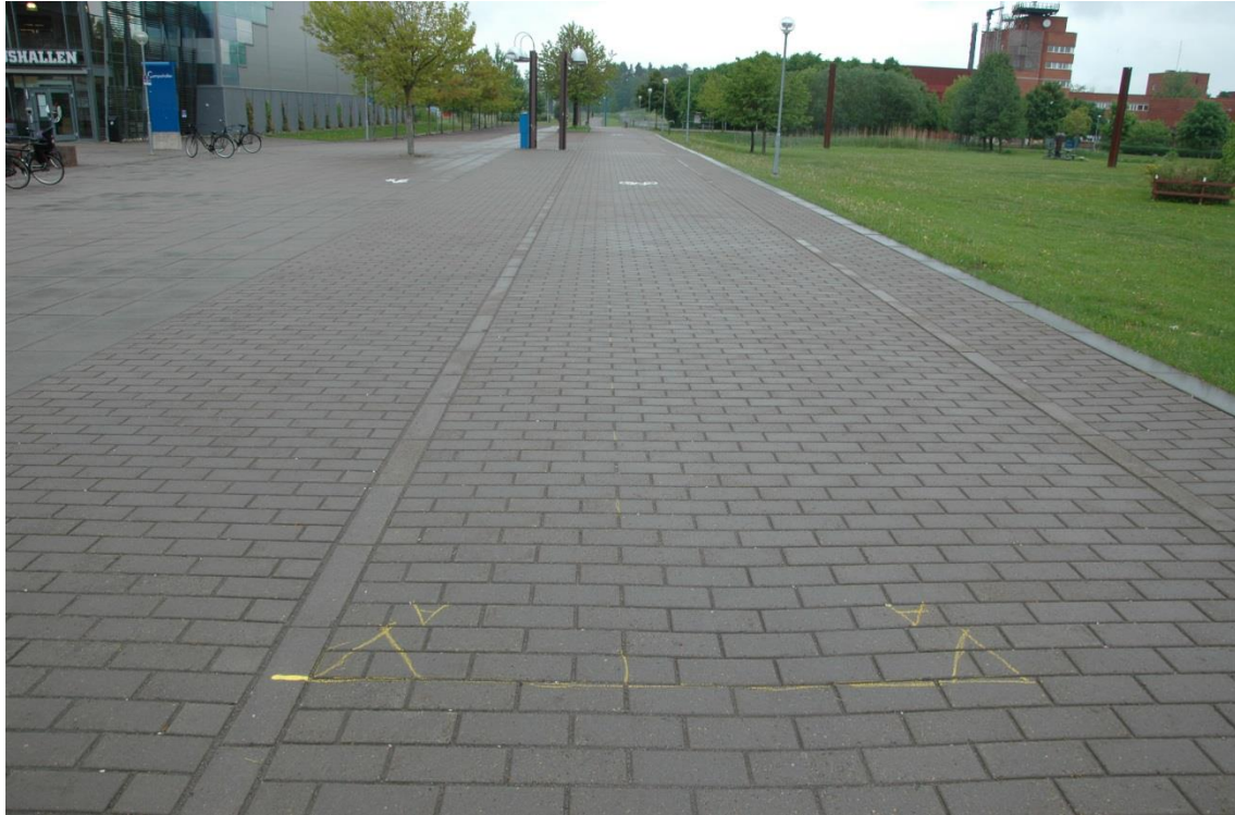
Figur 22 Teststräcka A: en cykelbana belagd med små betongplattor med ett skarvavstånd på 10 cm.
