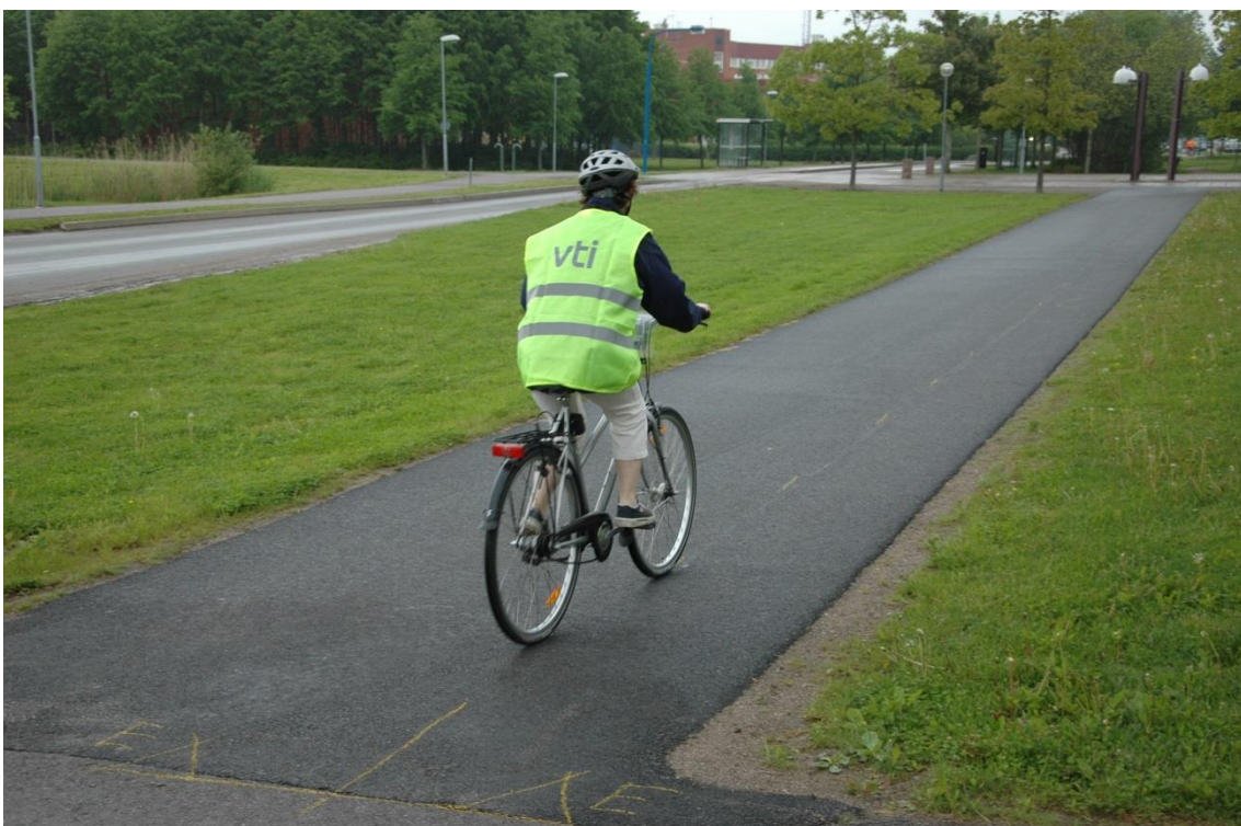
Figur 26 Teststräcka E: en gång- och cykelväg med nylagd asfaltbeläggning utan några synliga ojämnheter eller skador.
